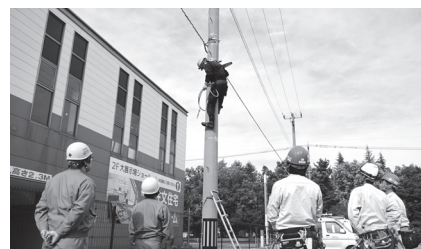
電柱作業の研修
