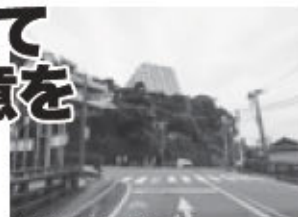
土砂災害による通行止め (2021年7月、熱海市)
