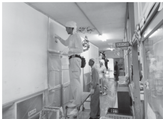
保育所の壁面の再塗装をしている様子
