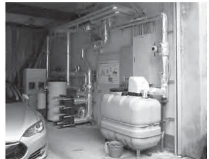
システムの実証試験で導入された地中熱ヒートポンプ
