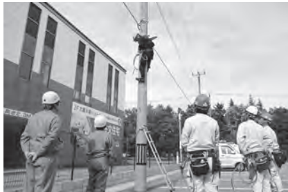
電柱作業の研修
