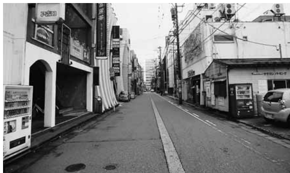
消雪装置は地区内の道路に張り巡らされている
