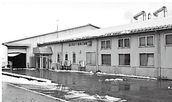
南砺市に立地する組合事務所
