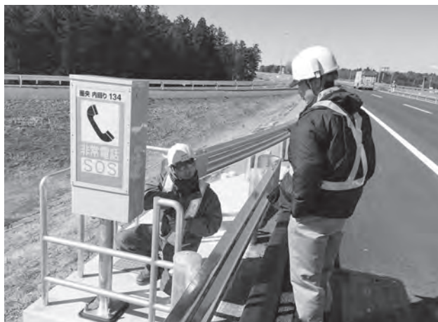
高速道路における電気通信工事
