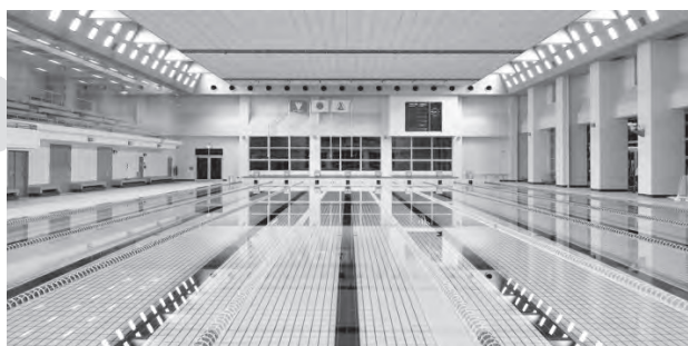
富山県総合体育センタープール
