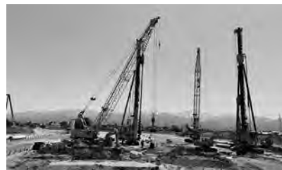
（情報提供：北陸信越コンクリートパイル協同組合）
