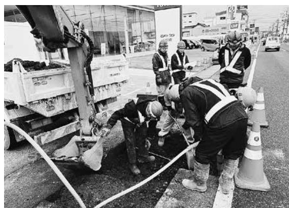
七尾市での復旧工事の様子
