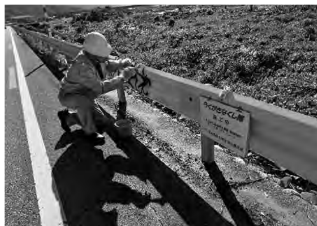
道路脇のガードレールの落書きを消す作業の様子
