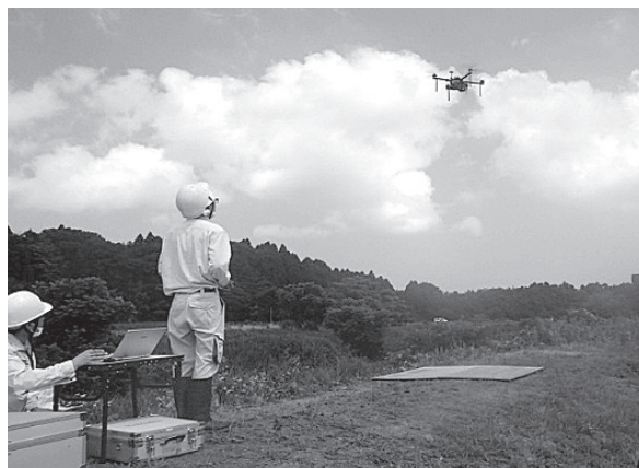
ドローンによる測量調査の様子
