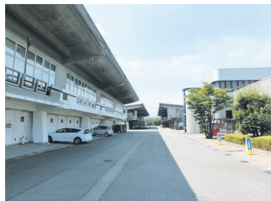
解体前の連棟式建物（左側）
