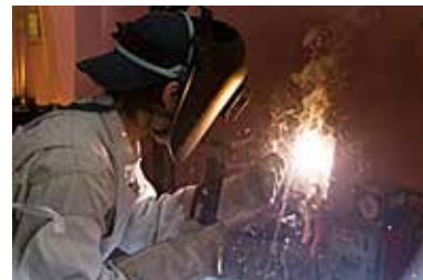
[中板突合せ立向き溶接]
